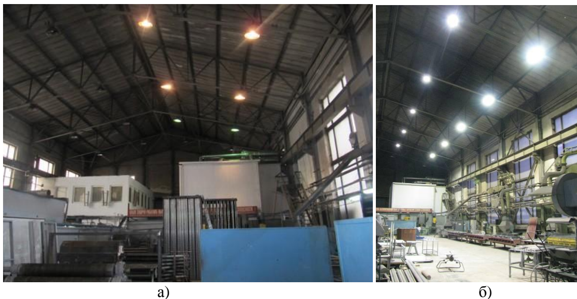
Рис. 6 – Фотографии цеха до и после модернизации его системы электроосвещения.
